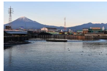
②潤井川河口沈砂池
