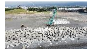
④海岸保全工事
