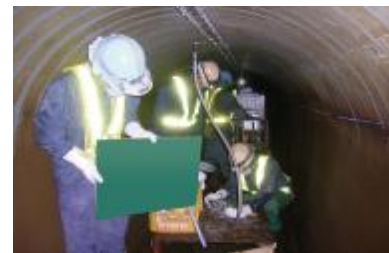
〈セットフォーム工法のウレタン注入〉
