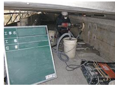
〈セットフォーム工法のウレタン注入〉
