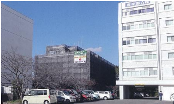
外壁改修その他工事
