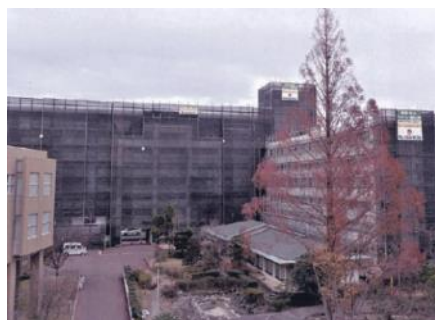
建物塗装・防水工事例
