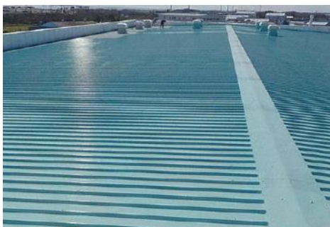
屋根塗装・防水工事例
