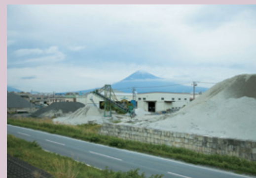
広大な作業敷地
