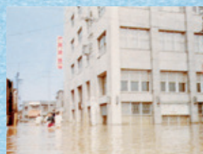
七夕豪雨の被害
