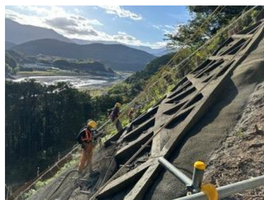
在来線の法面整備の例
