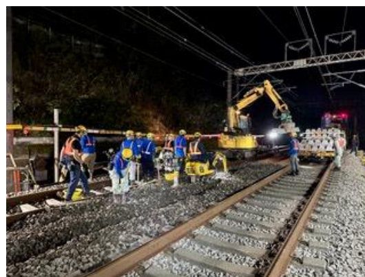
新幹線の線路補修作業の例
