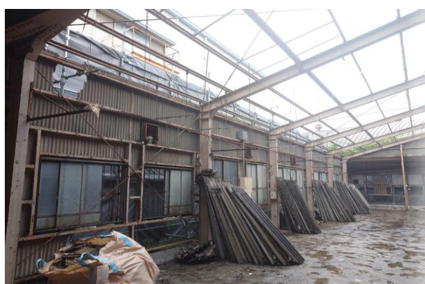
現場解体廃材の分別管理の事例
