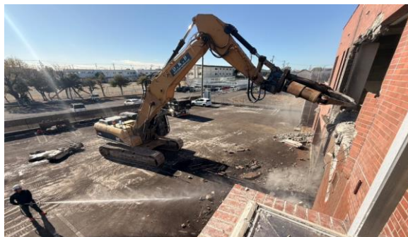
店舗(鉄筋コンクリート)解体事例
