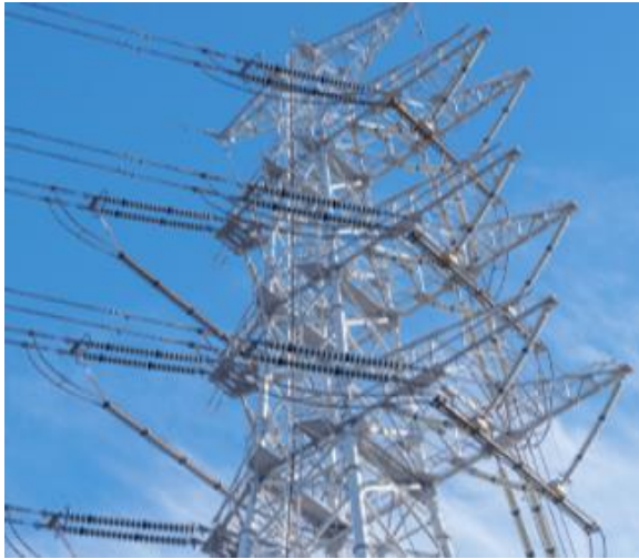
送電線鉄塔塗装工事
