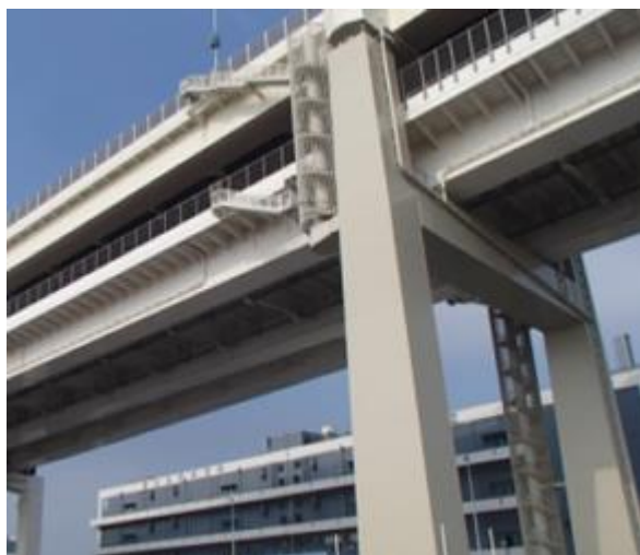
高速道路塗装工事
