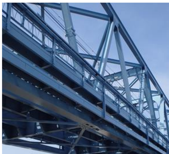
鉄道橋梁塗装工事
