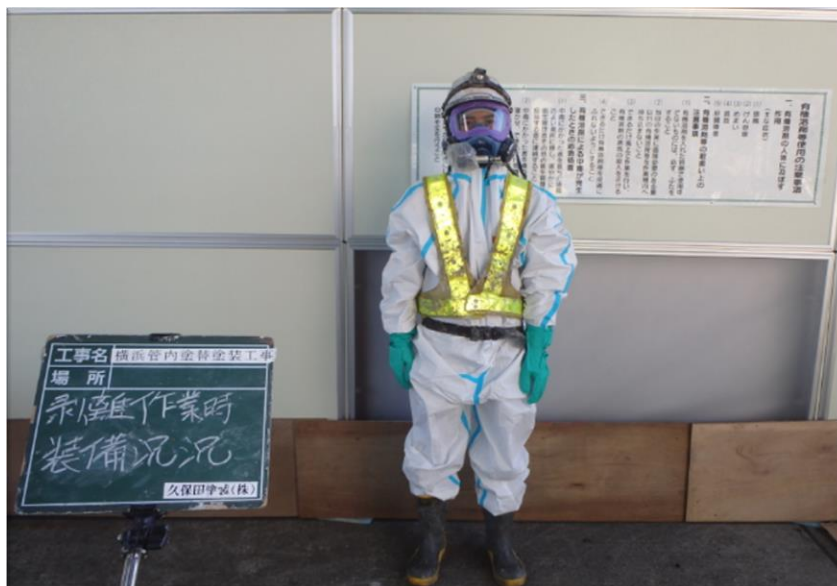
剥離作業前の装備
