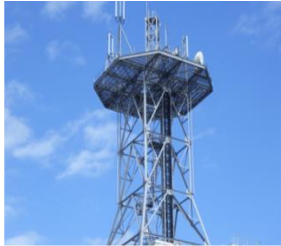
電波塔塗装工事
