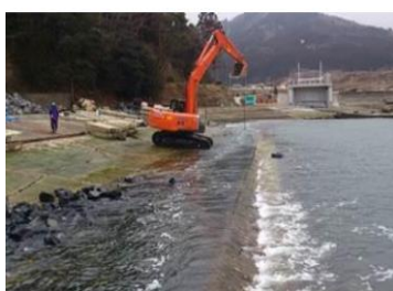
物揚場の復興工事（宮城県）
