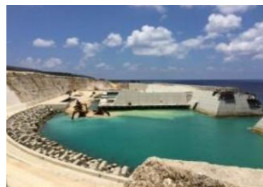
離島の漁港整備（沖縄県）
