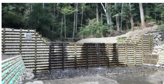
河川復旧工事（静岡県）
