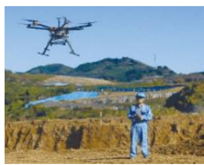
ドローン型レーザースキャナ測量
