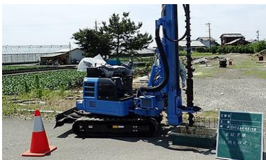
水はけ改善工事
