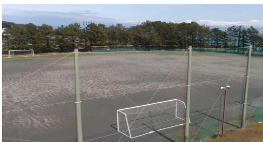
グラウンド造成工事（施工前→施工後）
