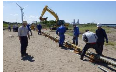
風力発電送電ケーブル敷設工事
