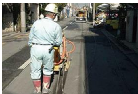
カッター工事
