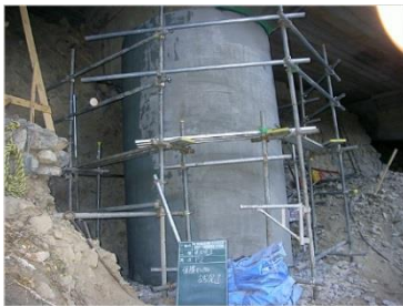
保護モルタル仕上げ完成
