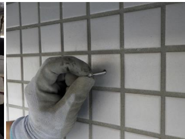
③アンカー設置
