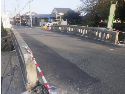
拡幅用鋼材取り付け
