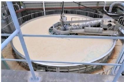
1次処理から3次処理までの浄化システムにより、公的基準よりも厳しい独自の浄化基準を設け、環境に配慮してトイレトーパーを製造している。時間当たりの水の使用量及び排出量を333 m<sup>3</sup>以下となるよう厳守していく必要性を確認した。
