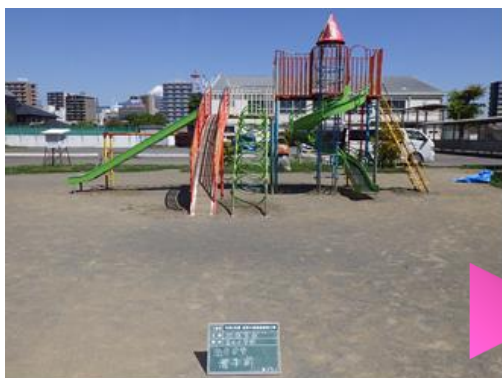
作業前：塗装が傷み、錆も目立つ。
