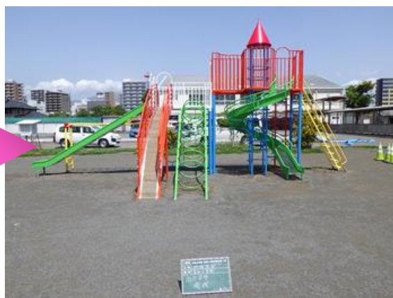
作業後：全体の塗装を剥離し、再塗装を実施した
