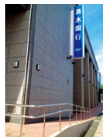
店舗入口へのスロープ
