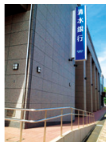
店舗入口へのスロープ
