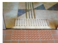
点字ブロック
