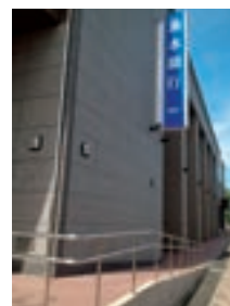
店舗入口へのスロープ
