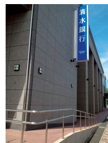
店舗入口へのスロープ
