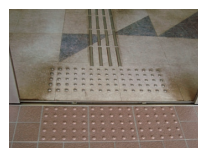
点字ブロック
